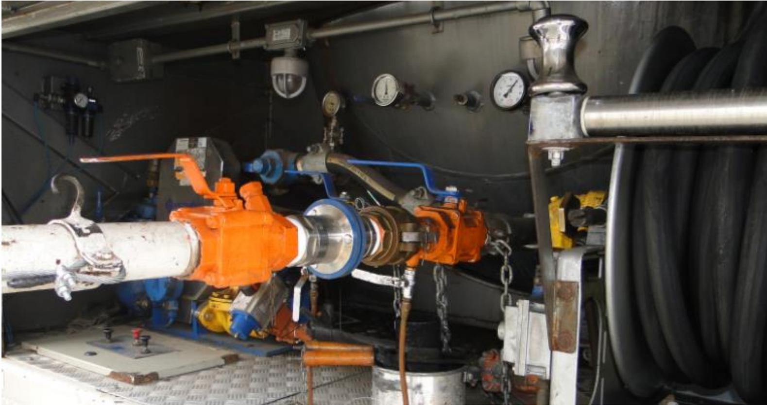
Carregamento de GLP. Braço de carregamento equipado com válvula de segurança por afastamento (fase líquida).
