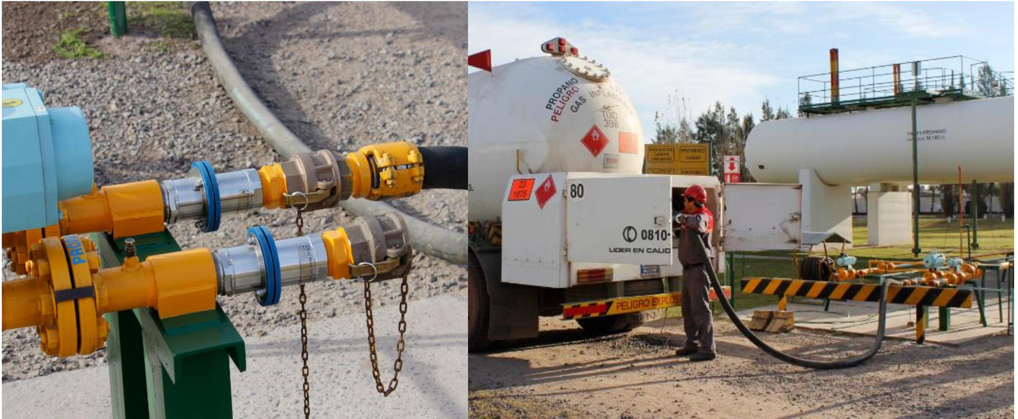
Carregamento de GLP. Instalação equipada com válvula de segurança industrial em 2”(fase líquida e vapor).
