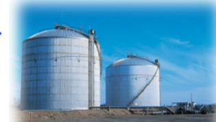
Terminales de Distribución
