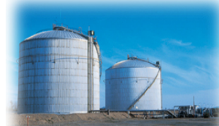
Terminales de Distribución
