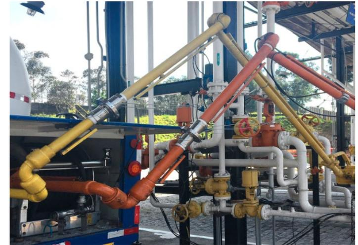
**Antes de la desconexión:** dos válvulas unidas por tres tornillos.
